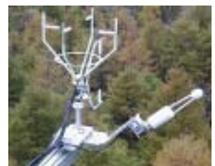
傾斜センサー取付例 2m 7-4m の先端、超音波風速計手前に取付
